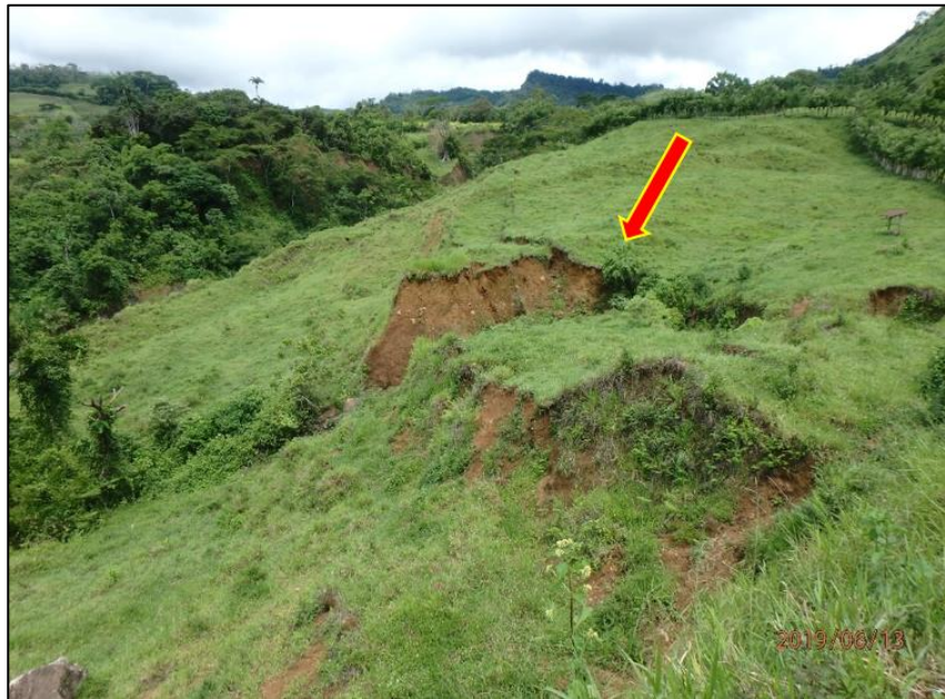
Fotografía A.1.10 Grietas transversales siguiendo valles secundarios - laderas activas. Coordenadas 597604.62E - 979157.39N.
