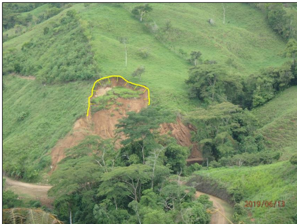
Fotografía A.3.6 Inestabilidad local en el sector NE de la zona de estudio - deslizamiento Paraíso. Producida por explotación de tajo. Coordenadas 595577.74E - 979352.84N.
