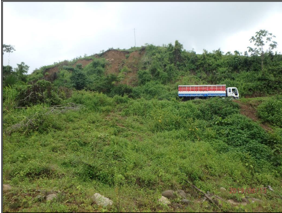
Fotografía A.4.3 Deslizamiento local que afecta el camino de Paraíso en el sector cercano a la torre de telefonía celular del ICE. El camino con frecuencia se ve afectado por el desplazamiento del terreno. Coordenadas 595987.34E - 978715.86N.
