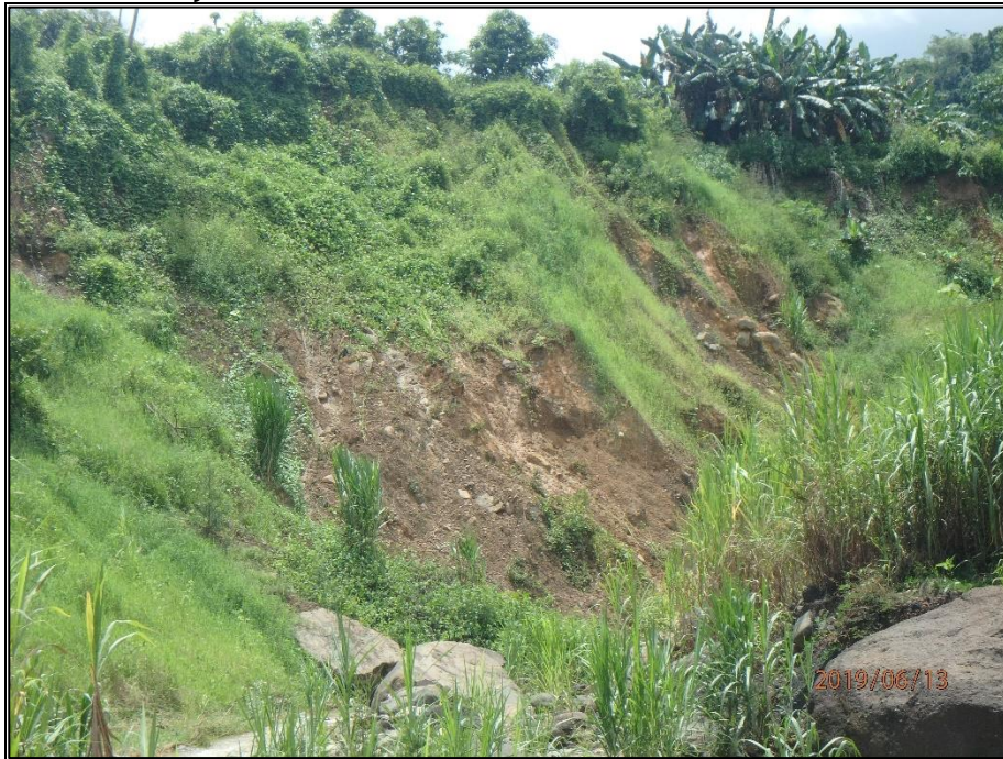
Fotografía A.1.18 Laderas inestables de la quebrada Paraíso, con espesores de 30 - 35 m de altura. Coordenadas 598046.55E - 978793.04N.
