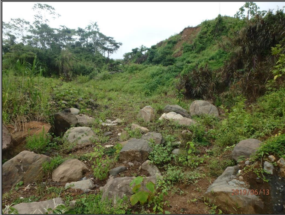
Fotografía A.4.1 Deslizamiento local que afecta el camino de Paraíso en el sector cercano a la torre de telefonía celular del ICE. Coordenadas 595987.34E - 978715.86N
