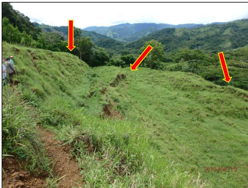
Fotografía A.1.11 Escarpes y grietas longitudinales a lo largo del cauce principal Quebrada Paraíso Central - laderas activas, desplazamientos permanentes. Coordenadas 597749.03E - 979081.58N.
