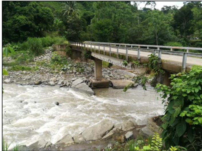
Figura 3.59. Estado actual del puente sobre el río Limón (Julio, 2019)
