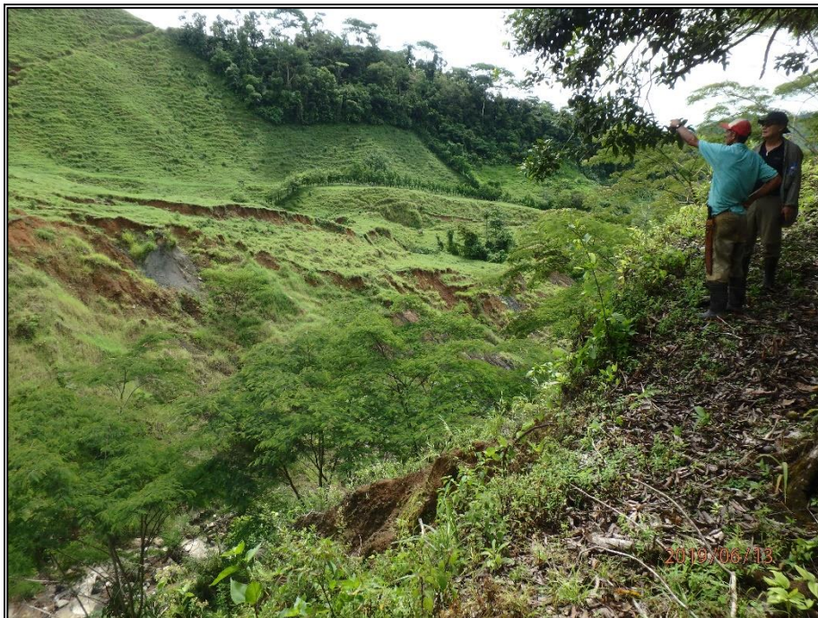
Fotografía A.1.4 Abundantes grietas producto de superficies activas - deslizamiento activo, límite superior - Norte. Coordenadas 597039.87E - 979353.64N.
