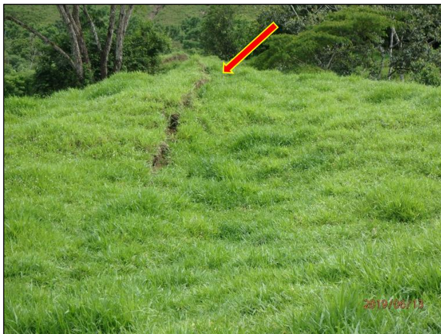
Fotografía A.1.2 Grieta que representa el límite superior del deslizamiento activo. Coordenadas X=597087.98E - 979083.60N.
