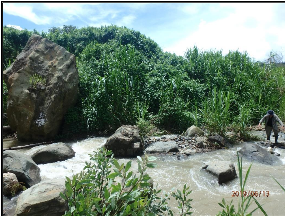
Figura 3.23 En algunos sectores de la quebrada Paraíso se observan bloques arrastrados con diámetros de hasta 2 m. Coordenadas 597912.80E - 978815.91N.
