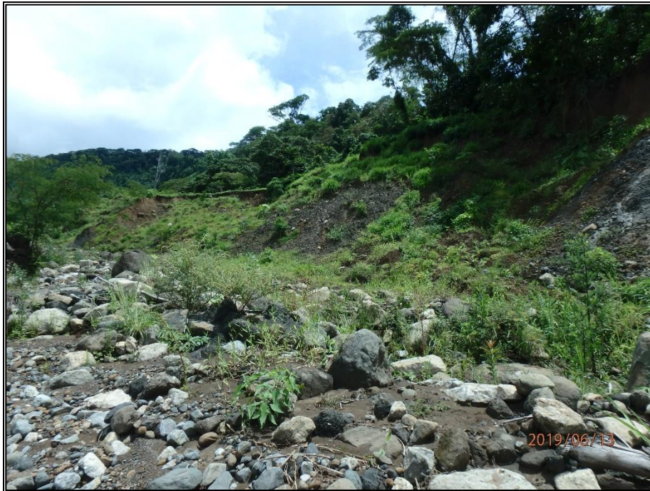
Fotografía A.1.15 Laderas inestables de la quebrada Paraíso, por tramos continuos de movimiento permanente. Coordenadas 597900.35E - 978844.58N.
