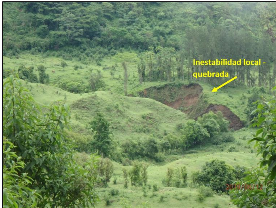
Fotografía A.2.5 Sector inactivo inferior - inestabilidad local muy frecuente - al borde las quebradas. Coordenadas 595754.89E - 979596.94N.
