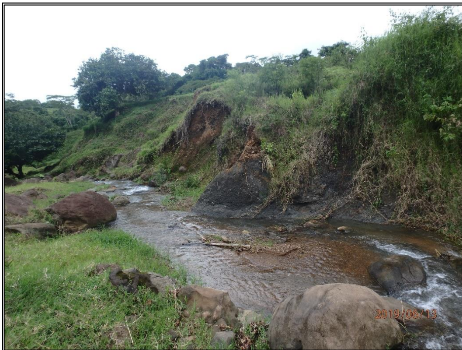
Fotografía A.4.4 Sector inestable cerca quebrada Paraíso Sur, cerca de la comunidad de Paraíso. Coordenadas 595807.09E - 978622.92N.
