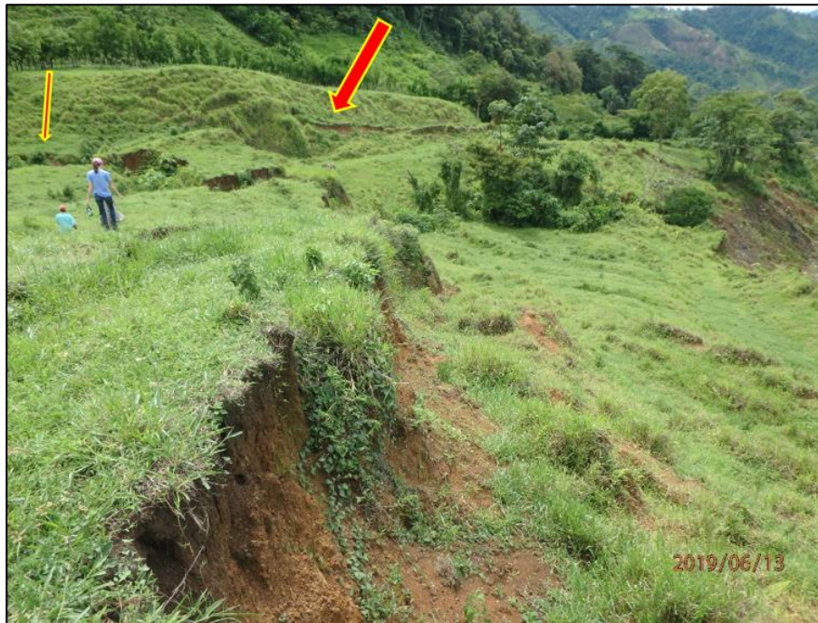
Fotografía A.1.9 Grietas longitudinales se observan a una distancia hasta a 100 m del cauce principal Quebrada Paraíso Central - laderas activas, desplazamientos permanentes. Coordenadas 597295.37E - 979342.67N.
