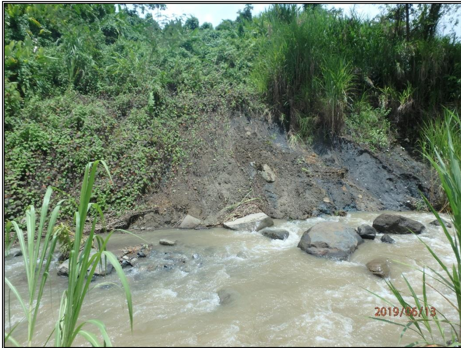
Fotografía A.1.17 Ladera inestable de la quebrada Paraíso, abundante contenido de limos y arcillas. Coordenadas 597954.90E - 978799.89N.
