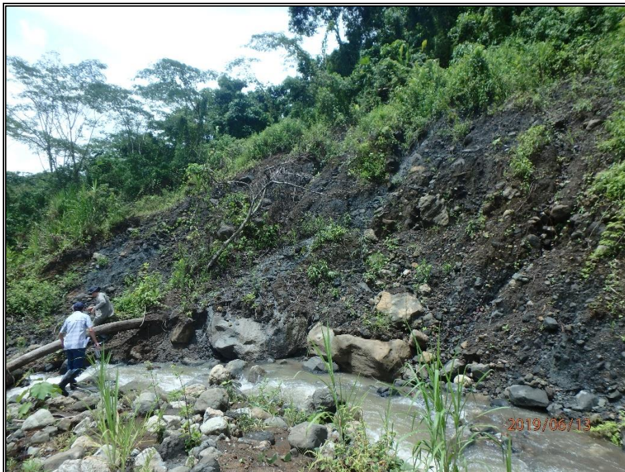
Fotografía A.1.16 Laderas inestables de la quebrada Paraíso, material brechoso con una matriz limo arenosa. Coordenadas 597954.90E - 978799.89N.
