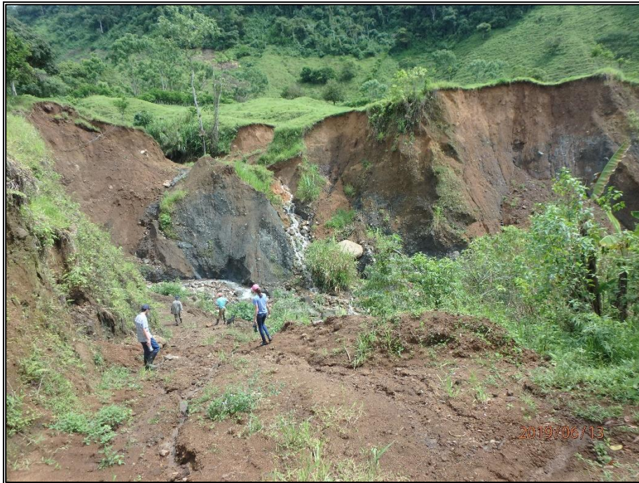
Fotografía A.1.5 Deslizamiento activo, quebrada Paraíso Central, laderas con movimiento permanente. Coordenadas 596853.38E - 979303.47N.
