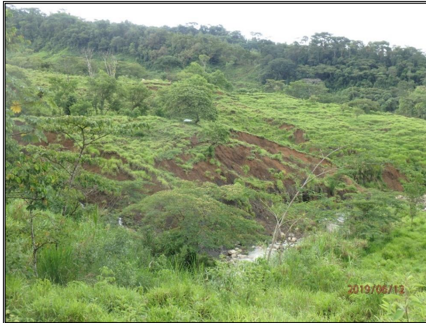
Fotografía A.1.1 Abundantes grietas longitudinales o paralelas a la quebrada Paraíso Sur producto de superficies activas y erosión del río - deslizamiento activo, sector central. Coordenadas 597764.75E - 978835.74N.
