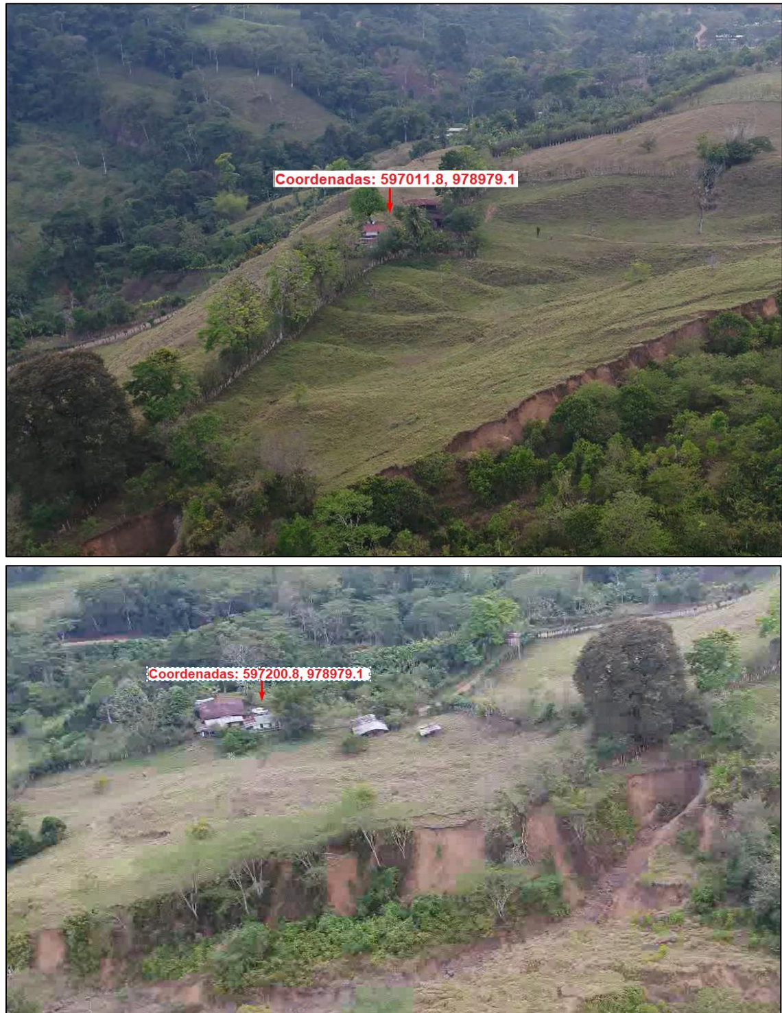
Figura 3.57. Edificaciones cercanas al área inestable (viviendas y construcciones agrícolas). Capturas de imágenes aéreas de sobrevuelo de la CNE, Marzo, 2019
