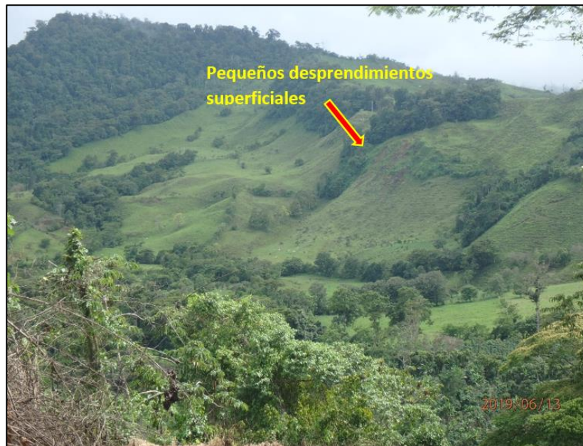
Fotografía A.3.5 Escarpe del deslizamiento en el sector NW-N, localmente se observan inestabilidades superficiales. Coordenadas 595115.47E - 979618.74N.
