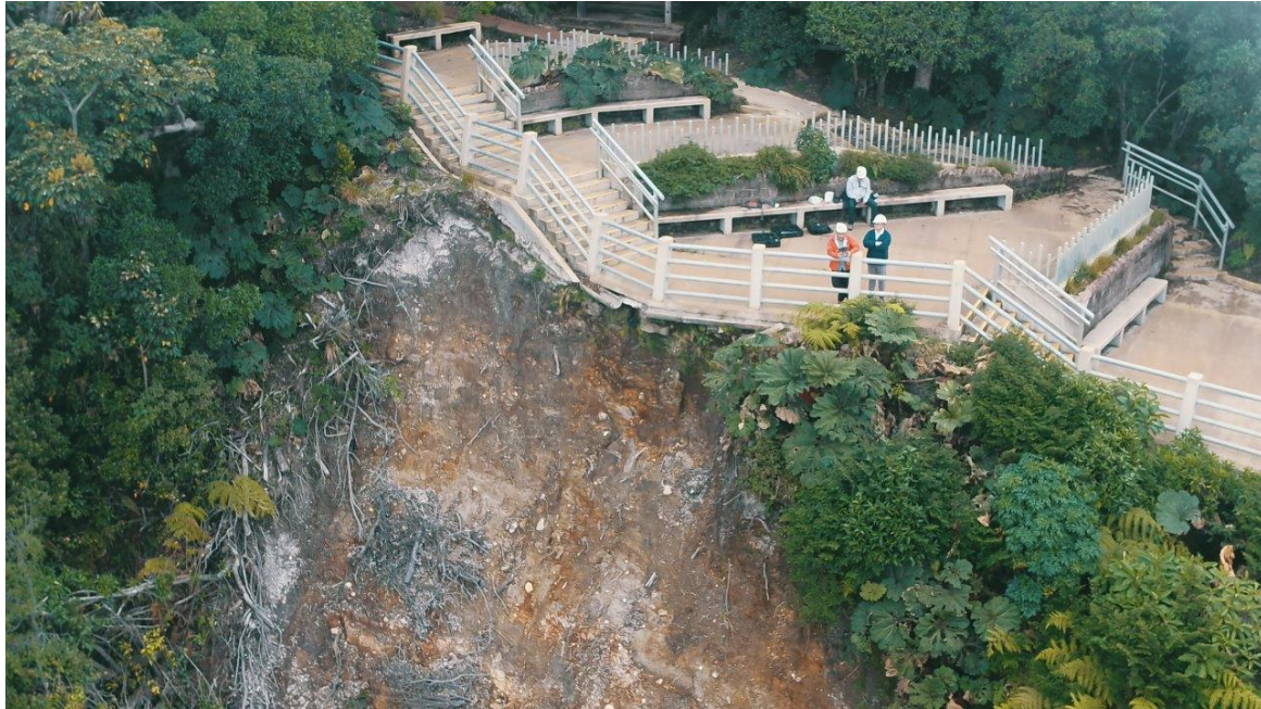
Fig. 46. Deslizamiento en el mirador del lago cratérico Votos asociado con las fuertes lluvias de la tormenta Nate, el 4-5 de octubre del 2018.
