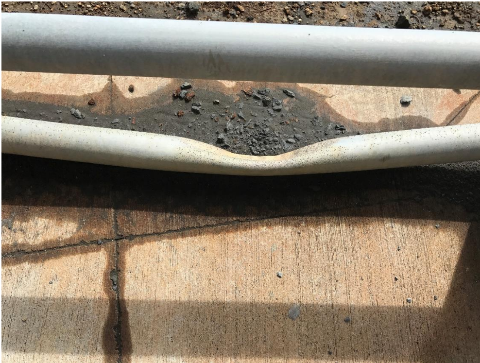
Fig. 39. Ejemplo de proyectiles balísticos y sus efectos en la infraestructura a raíz de la erupción del Poás en abril del 2017.
