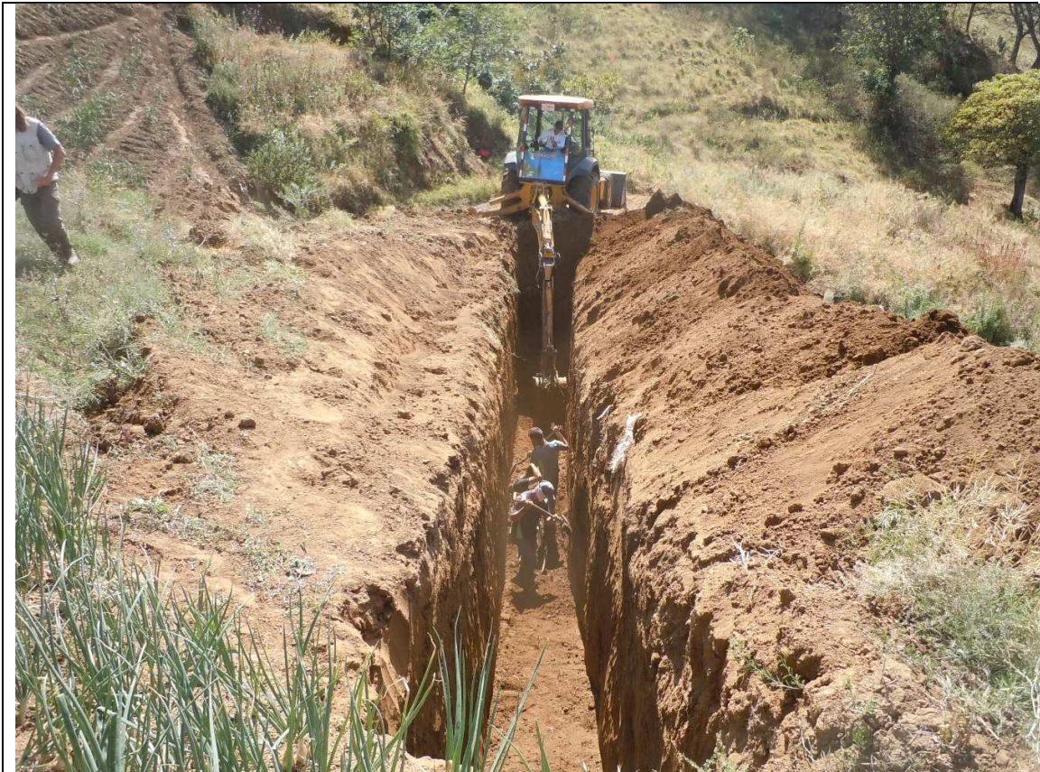
Fig. 5.17. Trinchera B, abierta en el terreno del señor Jaime Rojas, localizada aproximadamente a 2 Km al sur de la Ciudad de Zarcero (ver Figura 5.13 para ubicación).
