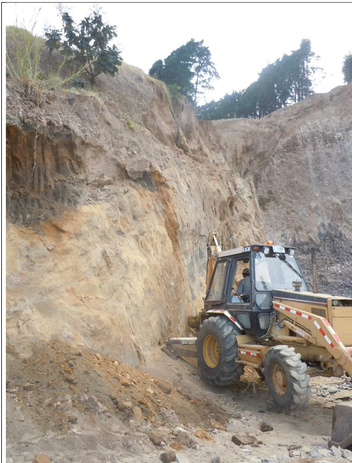
Fig. 5.22. Proceso de limpieza de las paredes del Tajo donde según la interpretación del Modelo Digital del Terreno pasa la traza de la Falla Zarcero atravesando el área del Tajo.
